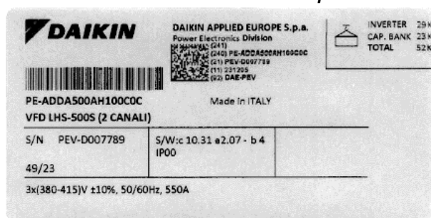
Kuva 31 – VFD LHS laitekilpi
