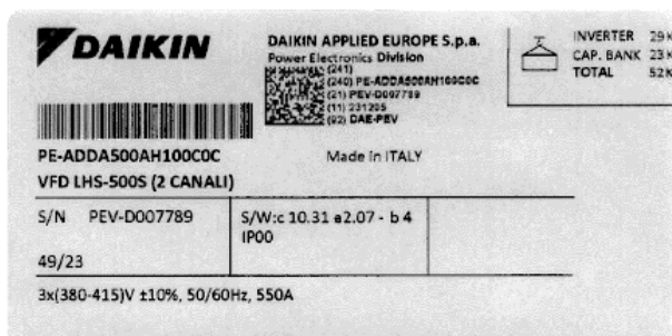
Slika 31– VFD LHS identifikacijska oznaka
