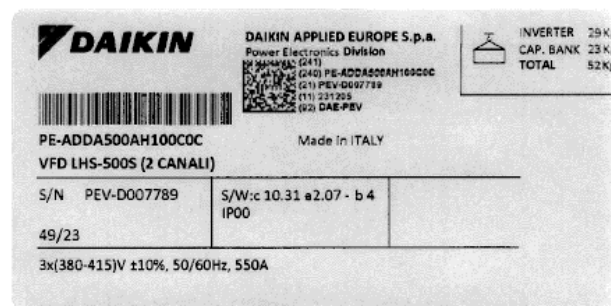
الشكل 18 - ملصق تعريف محرك التردد المتغير الأيسر
