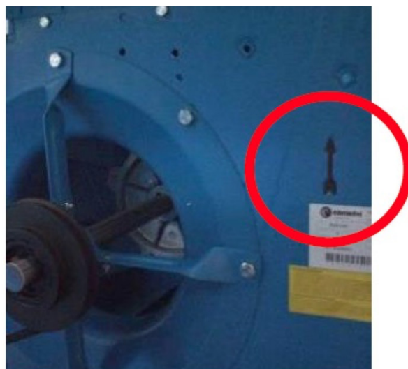
Ventilador de dupla aspiração
