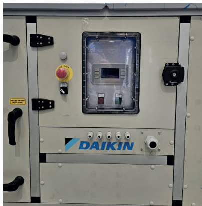
Вътрешно цифрово електрическото табло
