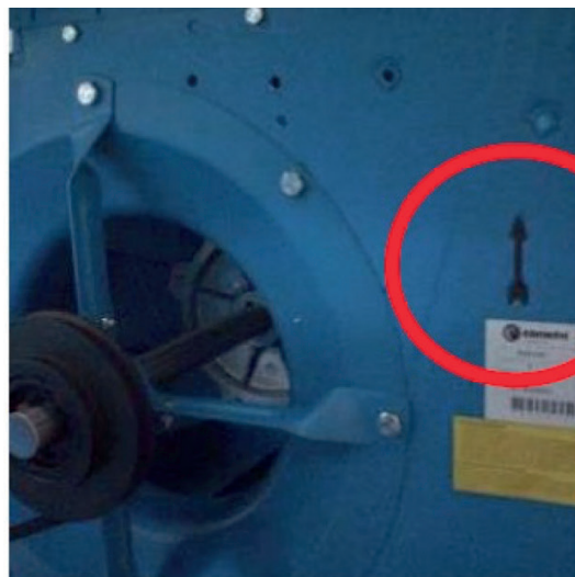
Ανεμιστήρας διπλής εισόδου
