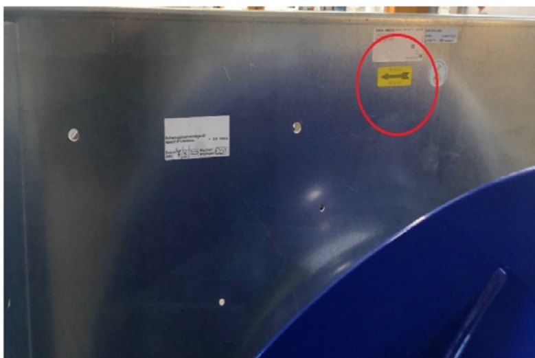
Plug fan (slobodni centrifugalni impeler bez kućišta)
