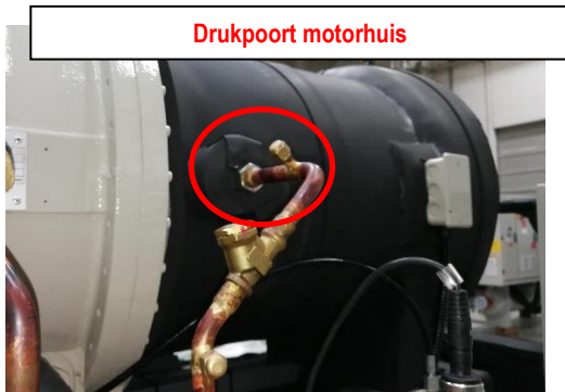
Detail motorhuis. Mogelijke aanwezigheid van restdruk in dit deel.
